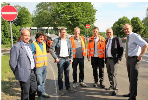
Auf der B 31-Baustelle
